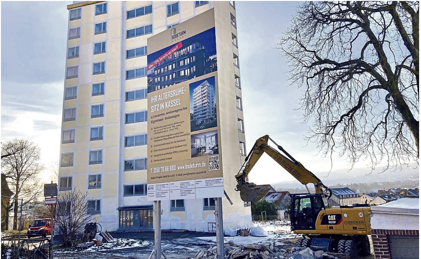
Abriß- und Entkernungsarbeiten haben begonnen: Bis Sommer 2026 soll der Bodeturm an der Sophienstraße 1 umgebaut werden.
